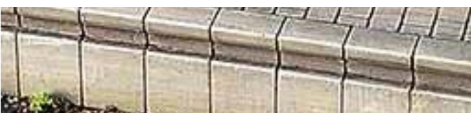
Afb.: Mallen 2214, 2215, hoog, betonelement met opstap
