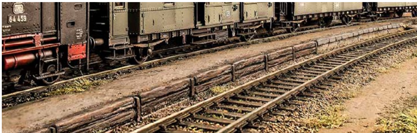
Afb.: Bulkspoorwegperron 2158 met dwarsliggers, achterzijde met stenen rand. 2159.
