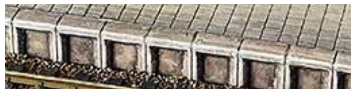
Afb.: Mallen 2238, 2218, laag, betonrand
