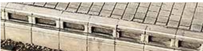
Fig.: Mallen 2214, 2215, hoog, betonelement met bevestiging
